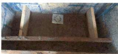
Foto 1: Este modulo de baños no cuenta con mingitorio, por lo que una tasa se eliminó y se esta construyendo un mingitorio de concreto.
