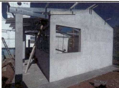
Foto 2: Esta cocina escolar solo cuenta con pared. Gracias a esta ayuda se esta colocando piso, ventanas, puertas, plancha, energia electrica, lavadero y se techará.
